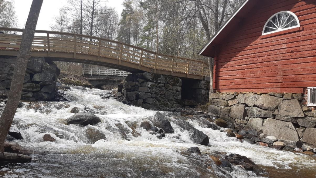
Kuva 7. Urpolan kalaportaat - Urpolanjoesta poistettiin virtakutuisten kalojen nousuesteenä toimineet Urpolan myllyn kohdalla oleva pato sekä myllyn yläpuolella oleva pohjapato.
