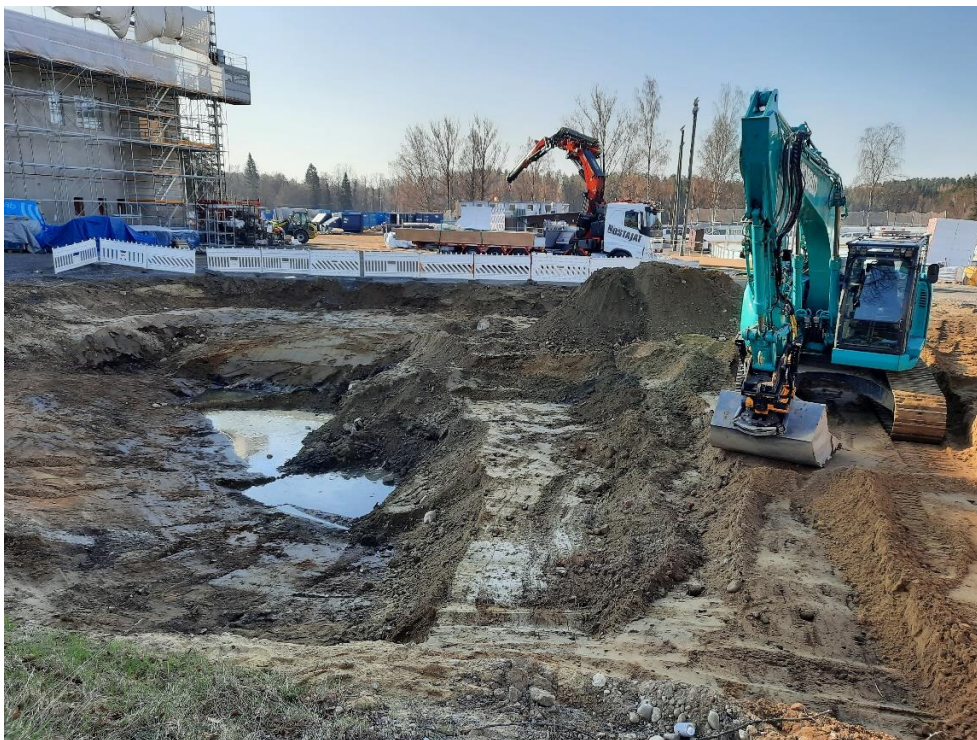
Kuva 8. Saimaanportin yhtenäiskoulun pilaantuneen maan kaivu keväällä 2023
